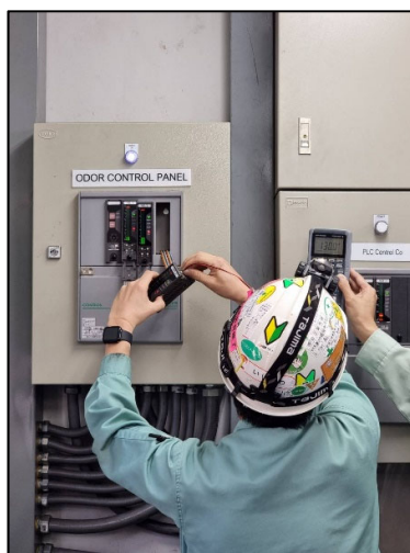
ภาพที่ 2.52 การสอบเทียบและบำรุงรักษาเครื่องวัดกลิ่นประจำปี 2565
