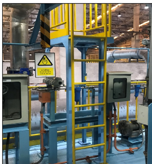
ภาพที่ 2.45 ระบบบำบัดกลิ่นแบบพลาสมาเย็น (Cold Plasma)
