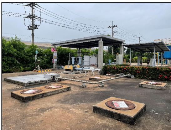
ภาพที่ 2.11 บ่อรวบรวมน้ำทิ้งของโครงการ (Holding Pond)
