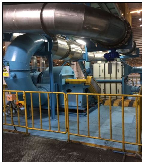
ภาพที่ 2.45 ระบบบำบัดกลิ่นแบบพลาสมาเย็น (Cold Plasma)
