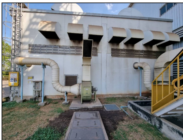
ภาพที่ 2.15 การระบายน้ำทิ้งจากระบบ Air Compressor
