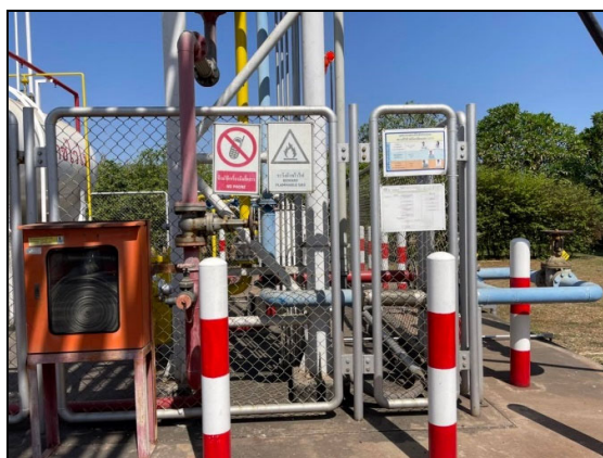
ภาพที่ 2.47 ป้ายเตือนอันตราย วิธีปฏิบัติเพื่อความปลอดภัย ตลอดแนวท่อส่งก๊าซ LPG
